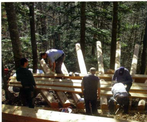
Bau des Gerüsts und des Bodens.
