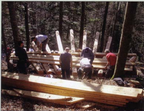
Montage de la charpente et du plancher.
