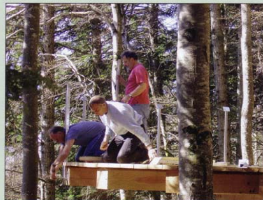
Montage de la barrière de sécurité.
