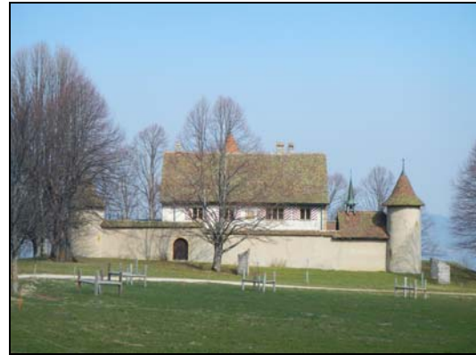
Vue du château depuis le nord
