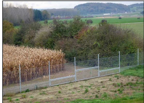
Les passages à faune permettent de diriger les animaux sauvages lorsqu'ils traversent la base aérienne
